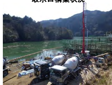
取水口構築状況
