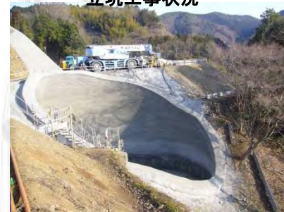
立坑工事状況
