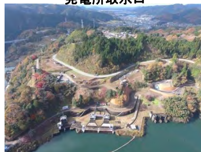
発電所取水口
