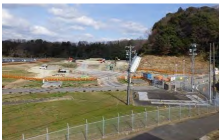
現場全景(2017/3/24現在)
