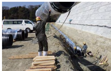
新設配管布設状況
