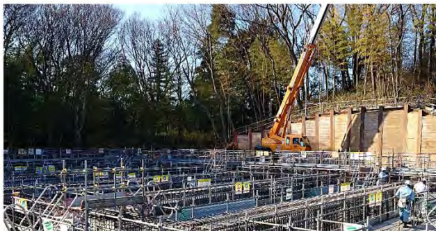
新設配水池(施工中)
