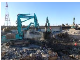
構造物撤去工
