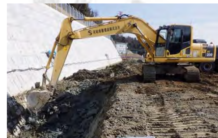
地山掘削状況
