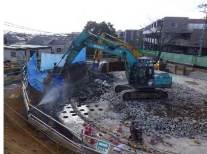
【PCタンク解体状況2017.1.10】
