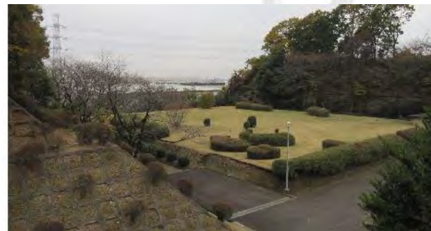
既設配水池(地下)
