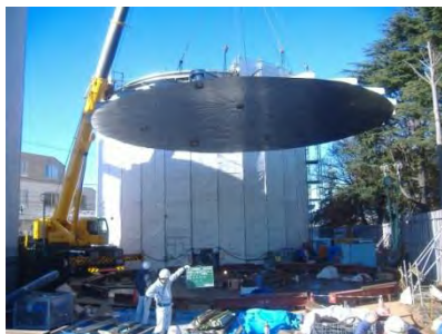
【屋根搭載状況2015.12.5】
