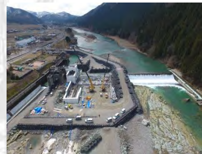
3期施工中(半川締切り)
