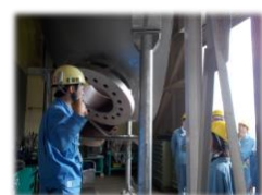
蒸気発生器内部作業 (コース4)
