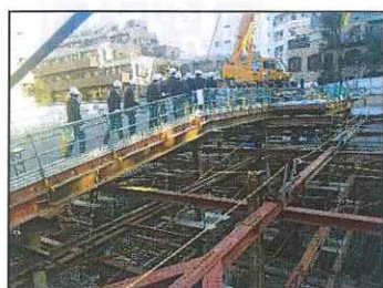
施工現場体験
